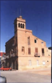
CASA DELS ARQUETS D'ALFARA
