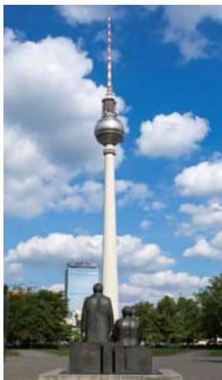
Torre de Telecomunicaciones
